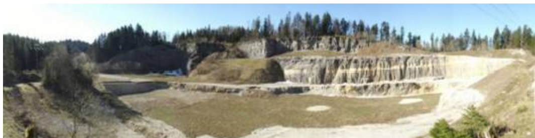
Vues récentes du site (cf. page 54 de l'étude d'impact). Point rouge : restaurant
